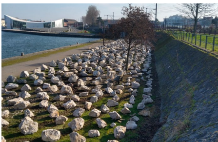
Photo de l'enrochement des quais, Calais © CFC
